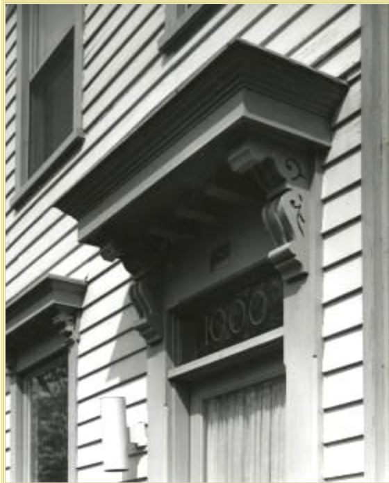
Door Hood Detail
